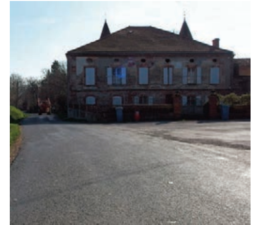
Place du village de Teulat (à droite) et RD28 (à gauche): espace routier (et donc destiné aux véhicules) plutôt que «vrai» espace public (permettant d'autres usages sur un espace agréable et sécurisé: piétons, jeux, bancs...)
