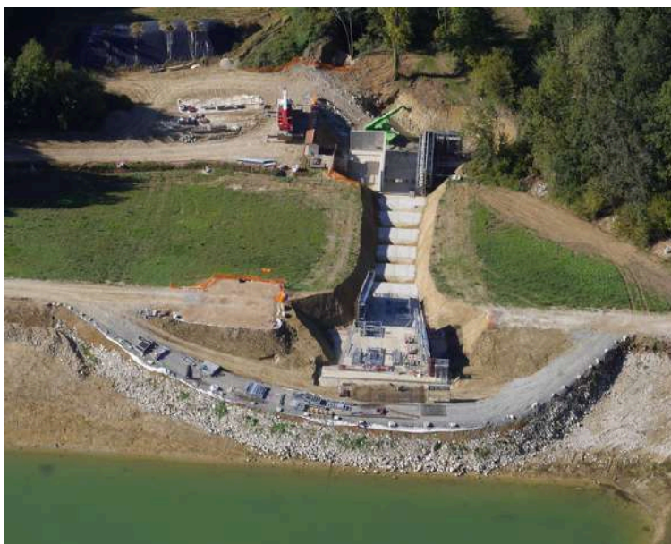
TRAVAUX SUR LA DIGUE DU LAC DE LA BALERME
